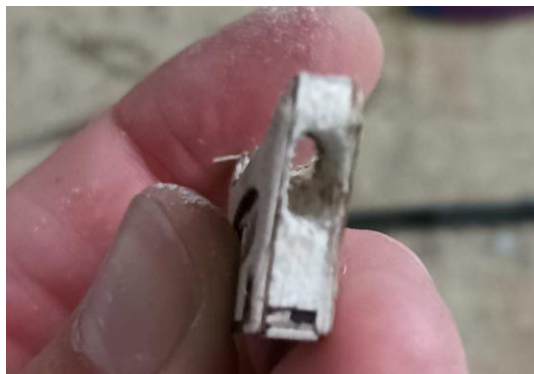
Passage de la gaine dans le pontet
